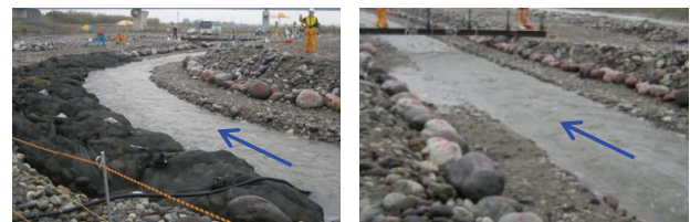
下流側蛇行部 上流直線部
