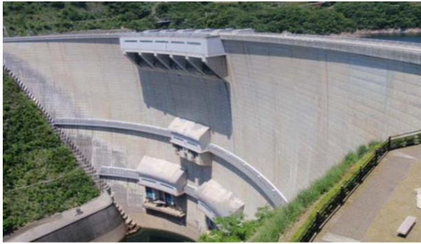
(b) 温井ダム
