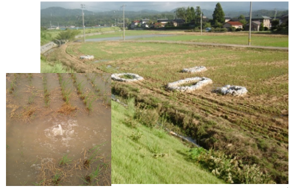
写真-2 荒木田地区(左岸9.5k付近)の漏水状況(漏水のみ) 9)
