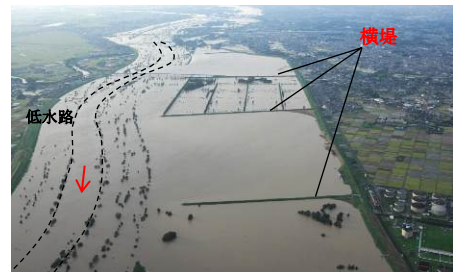
図-2 平成 19 年 9 月洪水時の治水橋 (41.9km) 付近の航空写真
