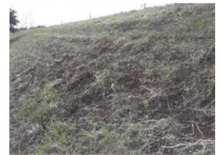
(c) 堤防表法表土抜け出し
