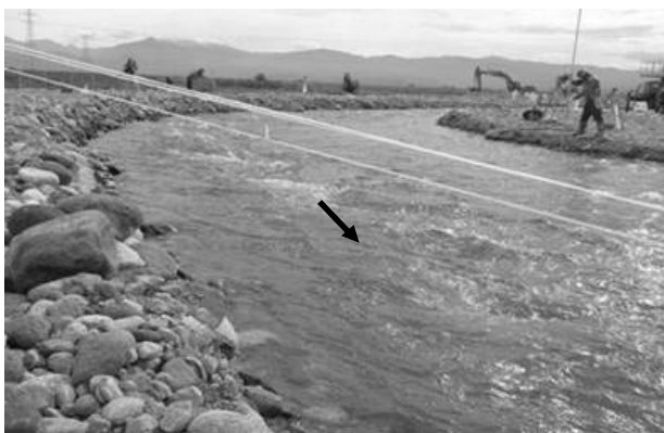
写真-4 実験水路満杯流量通水状況
