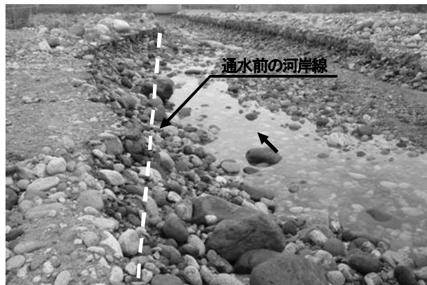
写真-6 通水後 (排水路)
