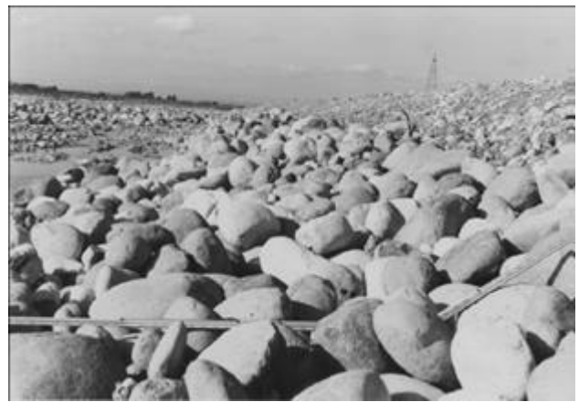
写真-2 ガラパック工法の施工状況
