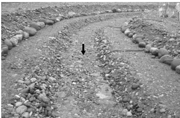
写真-3 通水前 (蛇行部)
