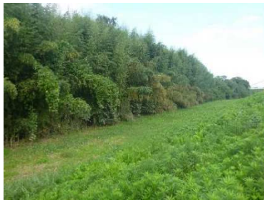
写真-1 高水敷の竹林密生域 (左岸8.5k付近)
