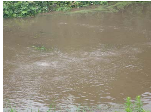
写真-2 漏水状況 (湧きあがり)
