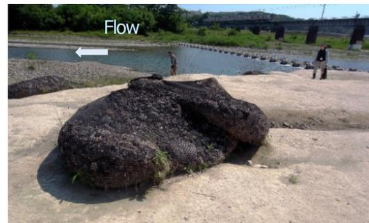
図-3 移動した袋詰玉石工の近景
