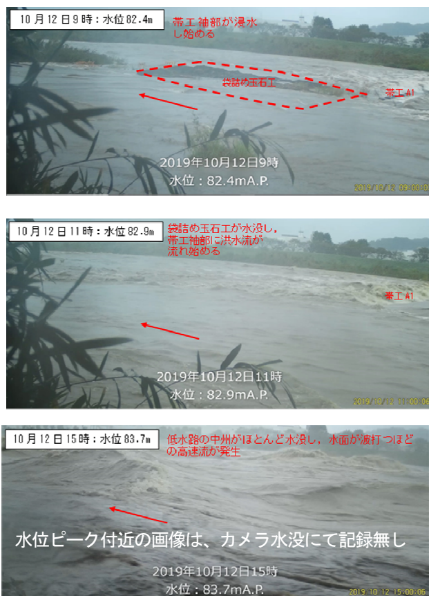
図-12 帯工A1周辺の洪水流下状況
