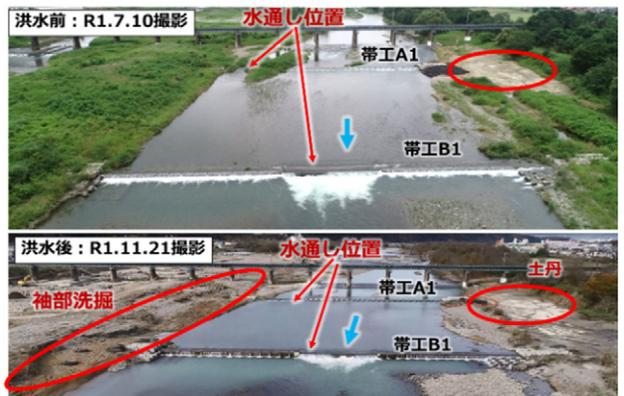
写真-1 帯工A1～帯工B1における洪水前後の斜め写真
