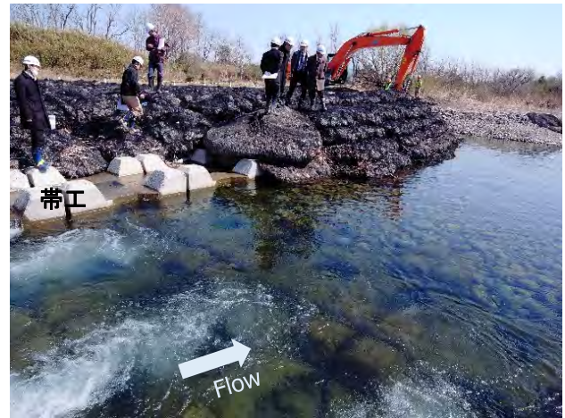
図15 新たに設置した帯工袖部の袋詰玉石工の全景 (2019/3/15 撮影)
