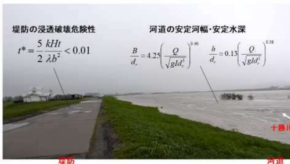
画像: 平成28年8月台風10号による十勝川の増水(豊頃町茂岩橋、ハルニレの木周辺十勝川左岸の映像) 2016.8.31, 10:30~11:30頃(撮影者片山昇一)
