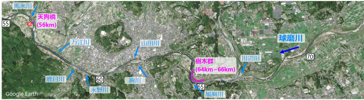
図-1 球磨川の55km~72km区間の航空写真と本検討で対象とする河道被害箇所
