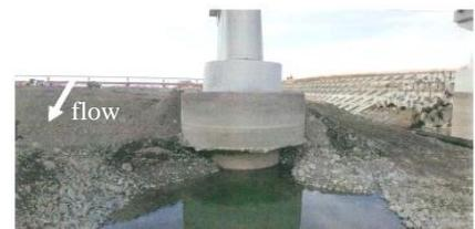
図-2 日野橋 P5 橋脚背面の洗掘<sup>3)</sup>
