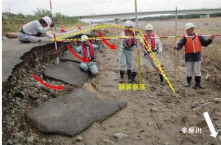
図-7 29.2k 付近での河岸侵食とサイクリングロードの舗装崩落<sup>4)</sup>
