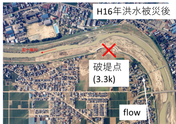
図-1 平成 16 年 7 月新潟・福島豪雨における破堤点 4)
