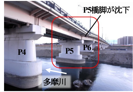
図-1 洪水前における日野橋周辺区間の航空写真と日野橋P5橋脚沈下の状況
