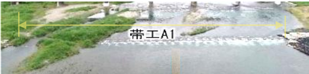
写真-3 部分突起型帯工:帯工A1の上に形成された砂州
