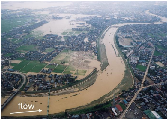
図-1 平成16年7月新潟・福島豪雨時の内岸堤防破堤の様子 1)
