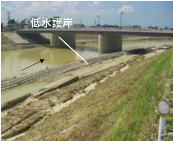
図-12 平成23年7月新潟・福島豪雨時の内岸高水敷・低水護岸洗掘被害状況 10)
