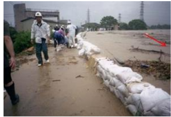
図-2 平成16年7月新潟・福島豪雨時の破堤部対岸の水防活動の様子 2)
