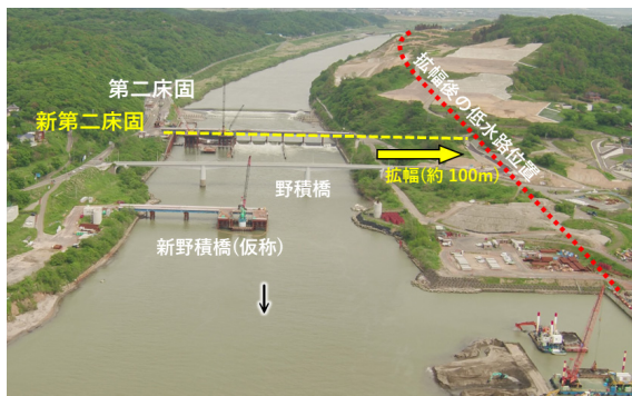
(a) 第二床固周辺の斜め写真(R4.5.16撮影)
