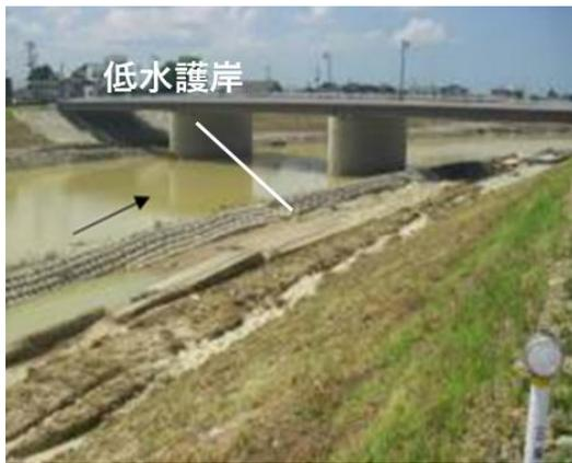
(a)内岸高水敷・低水護岸洗掘(1.1km内岸)
