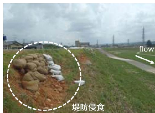
図-6 3.4km 外岸における堤防表法面侵食 2)
