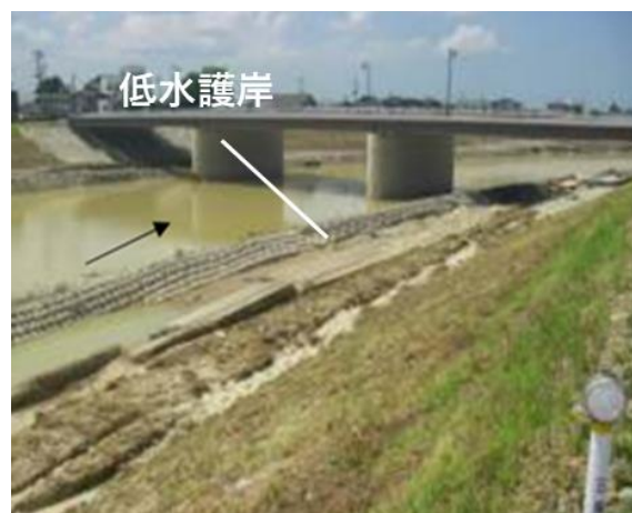
図-1 平成 23 年 7 月新潟・福島豪雨時の高水敷・低水護岸洗掘被害(1.1km 右岸) 2)
