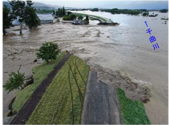
図-1 令和元年東日本台風時における堤防決壊地点の様子(57.4km 左岸) 1)
