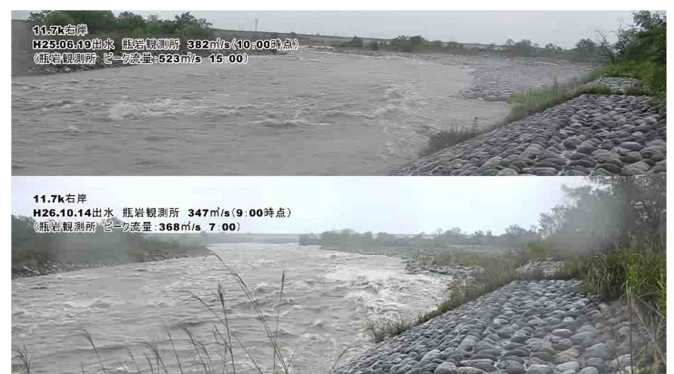
図-11 H25年6月出水とH26年10月出水(Q=367.9m 3 /s)のリップラップ部の状況
