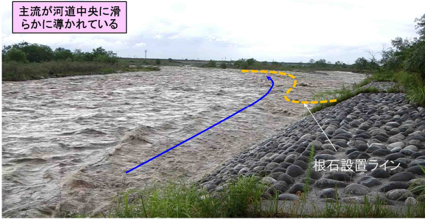
図-5 H25年6月出水の状況(常願寺川右岸11.7k付近)
