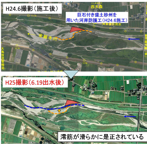
図-6 施工後～出水後の河道の変遷(常願寺川右岸11.7k施工箇所)
