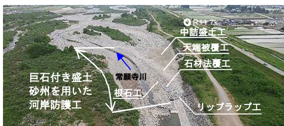
図-1 「巨石付き盛土砂州を用いた河岸防護工」全景
