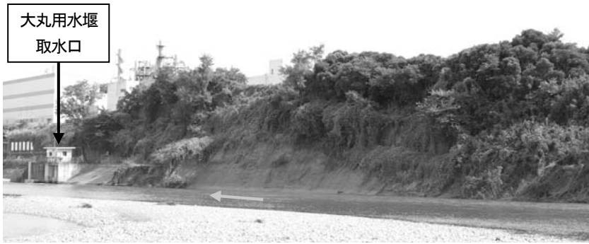
図-5 大丸用水堰上流の河岸侵食状況
