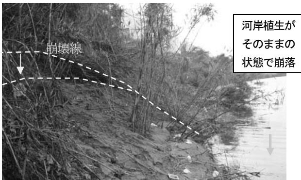
写真-2 崩落した河岸の状況
