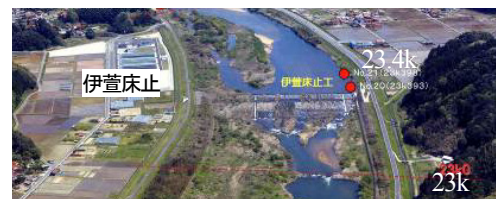
写真-1 伊萱床止め(平成23年撮影), 23.3k
