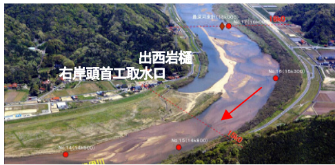
(a) 右岸頭首工取水口・出西岩樋
