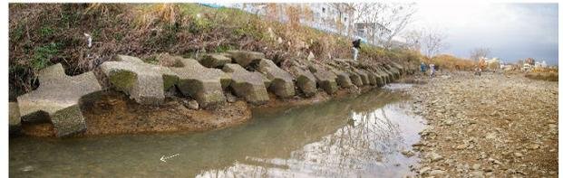
写真-5 浅川 9.2km 右岸水衝部の根固め工崩落状況
