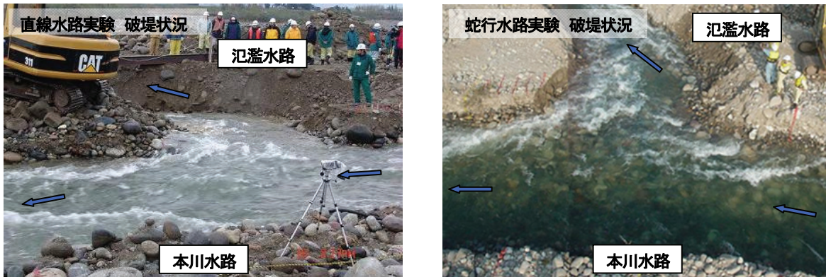
図-2 破堤状況写真
