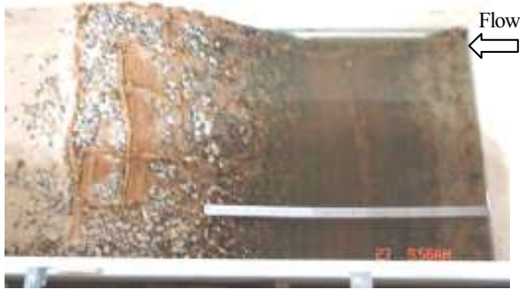
図-6 通水後の沈石の散乱状況(Case F3)
