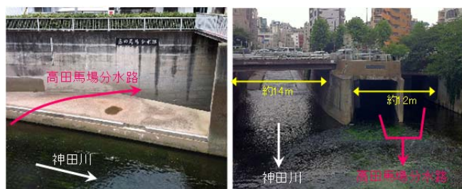
図-5 高田馬場分水路構造
