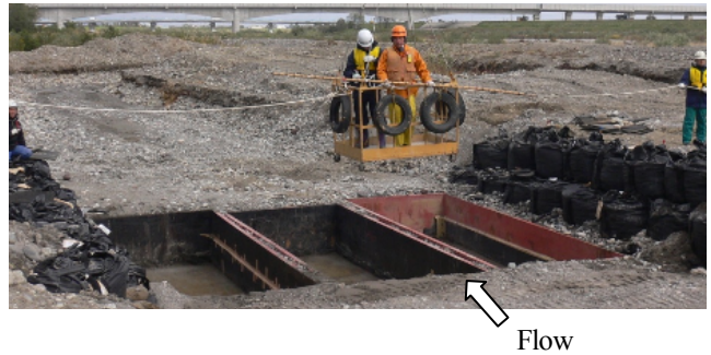
写真-2 常願寺川での下流端土砂貯めによる流砂観測
