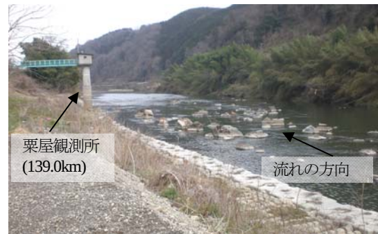
図-5 江の川栗屋観測所(141.6km)付近の河床の様子(平成23年4月撮影)
