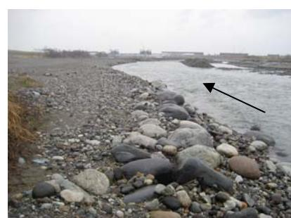
図-4 巨石付き盛土砂州の現地パイロット試験
