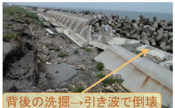
図1 護岸の海側への転倒
