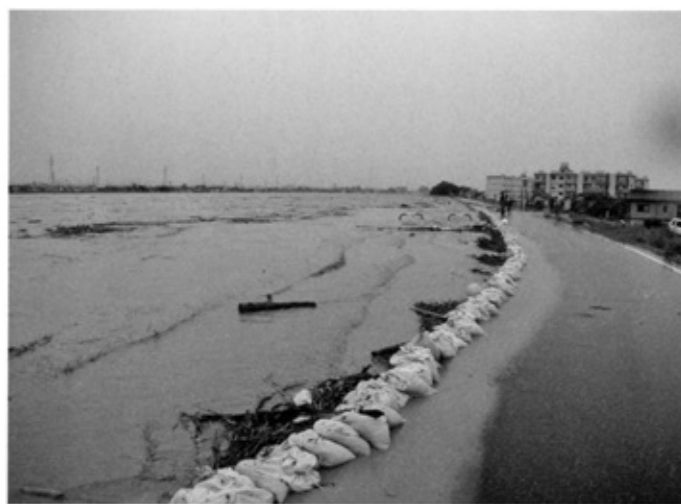
写真1 五十嵐川堤防天端上を流れる洪水流（新潟県三条市三竹）
