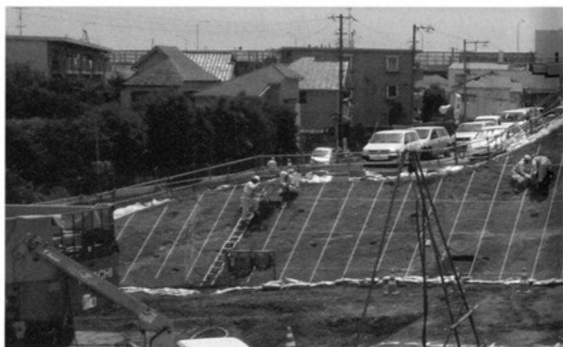
写真3 江戸川堤防の開削断面 (千葉県市川市大和田)
