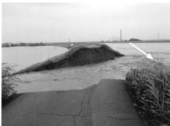
写真2 九州北部豪雨での矢部川堤防の決壊（福岡県柳川市大和町）
