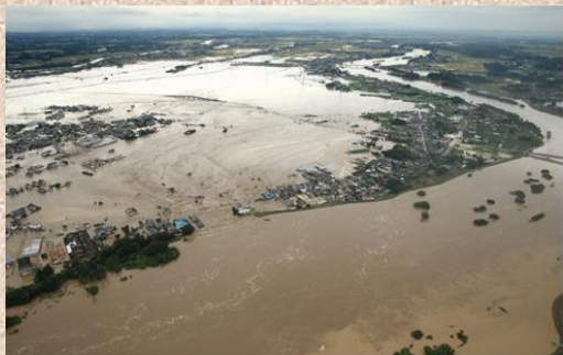
平成27年9月鬼怒川洪水時の様子 提供：国土交通省関東地方整備局
