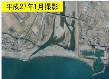
図-1 物部川の河口砂州洪水後の様子 (提供: 国土交通省四国地方整備局高知河川国道事務所)
