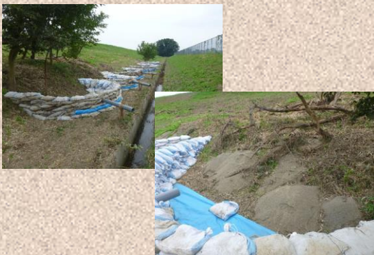
平成27年9月鬼怒川洪水時の基盤漏水
