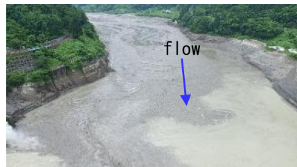
図-2 連携排砂時の貯水池内の様子
