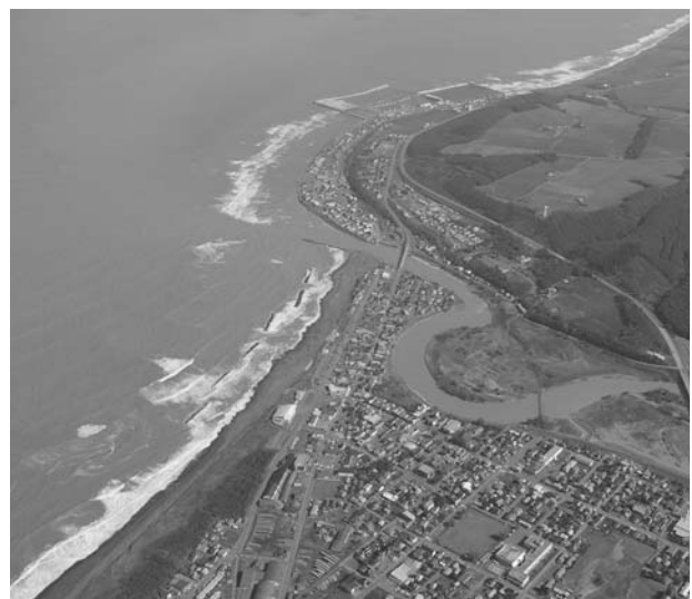
写真-1 海域への土砂流出状況(H18年10月洪水)
