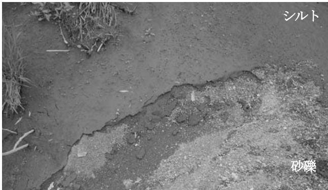
写真-2 H19年6月時 3.6km地点左岸砂州の土砂堆積
