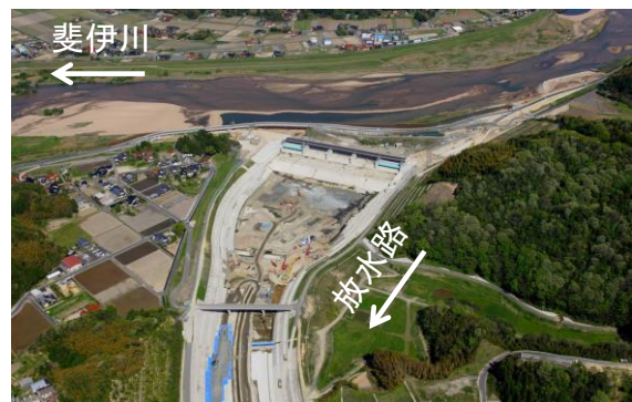
写真-2 分派点付近の航空写真 (平成24年4月撮影)
