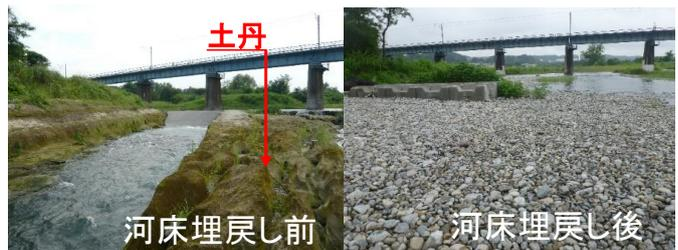
写真1 JR 八高線下流埋戻し状況
