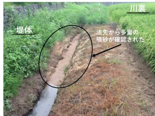
写真-1 梯川右岸 8.6k の被災状況
