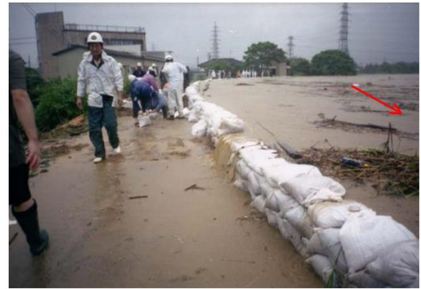
図-2 平成16年7月新潟・福島豪雨時の破堤点対岸での土嚢を用いた水防活動の様子 1)
