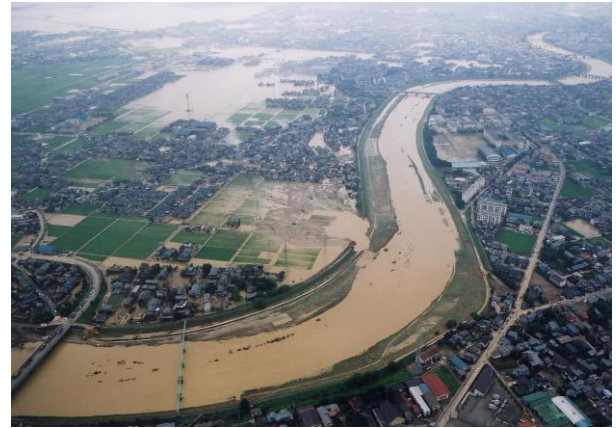
図-1 平成16年7月新潟・福島豪雨時における内岸堤防の破堤状況(3.3km)
