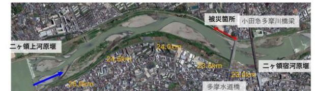
(c)被災箇所周辺の洪水後の航空写真(R2年4月)
