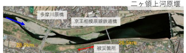
(b)被災箇所周辺の洪水前の航空写真(R1年5月)
