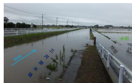
図-10 平成27年9月豪雨時の三尺排水路浸水被害状況
